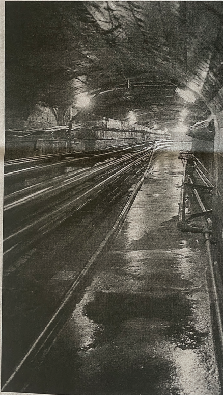
Einst lagerte in diesen Kavernen oberhalb Bolligen Benzin für den Kriegsfall. Nun wird das Tanklager aufgehoben. BILD PFAFFLI
